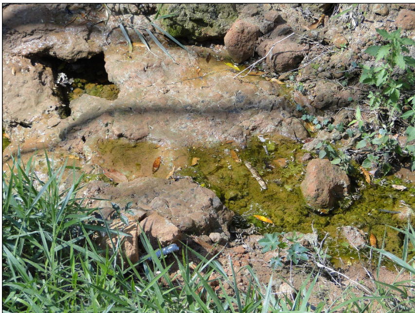
Figura 10. Surgência d'água (piping) no pé do talude da boçoroca descrita anteriormente, no município de Monte Alto – SP, observada em 2016
