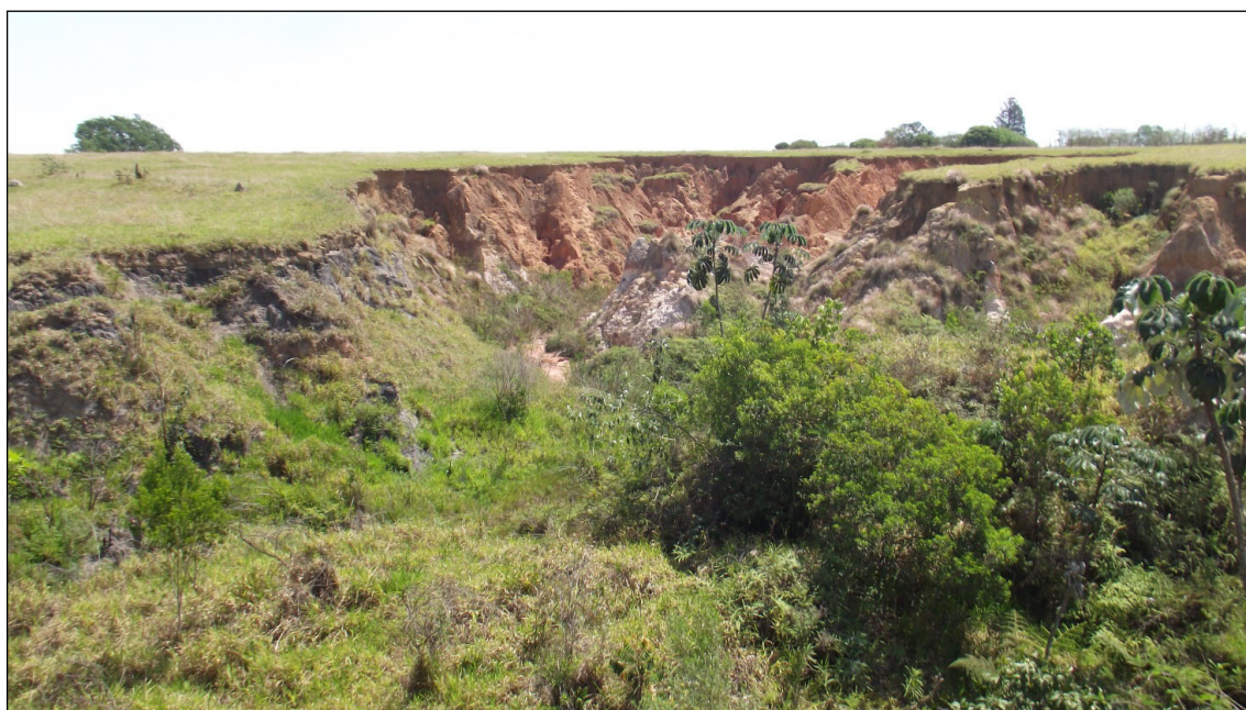
Figura 1. Ocorrência de boçoroca em área do município de Hortolândia - SP, registrada em 2014.
