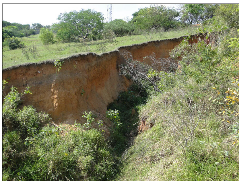
Figura 9. Outro aspecto da boçoroca descrita na figura anterior. Observar a inclinação do talude em solo areno-argiloso.
