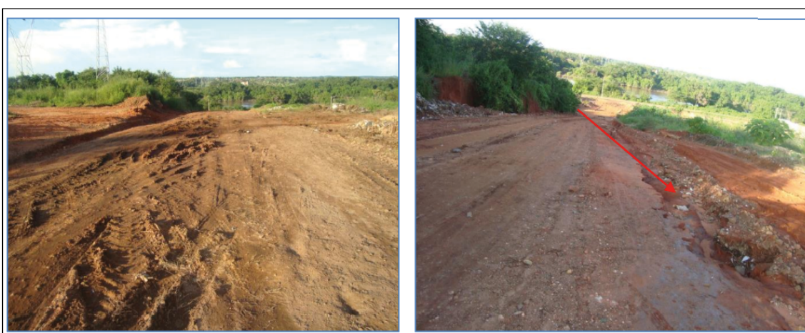
Figura 5. Vista da saída do dispositivo de drenagem e pista danificada por processos erosivos em avenida de Teresina.
