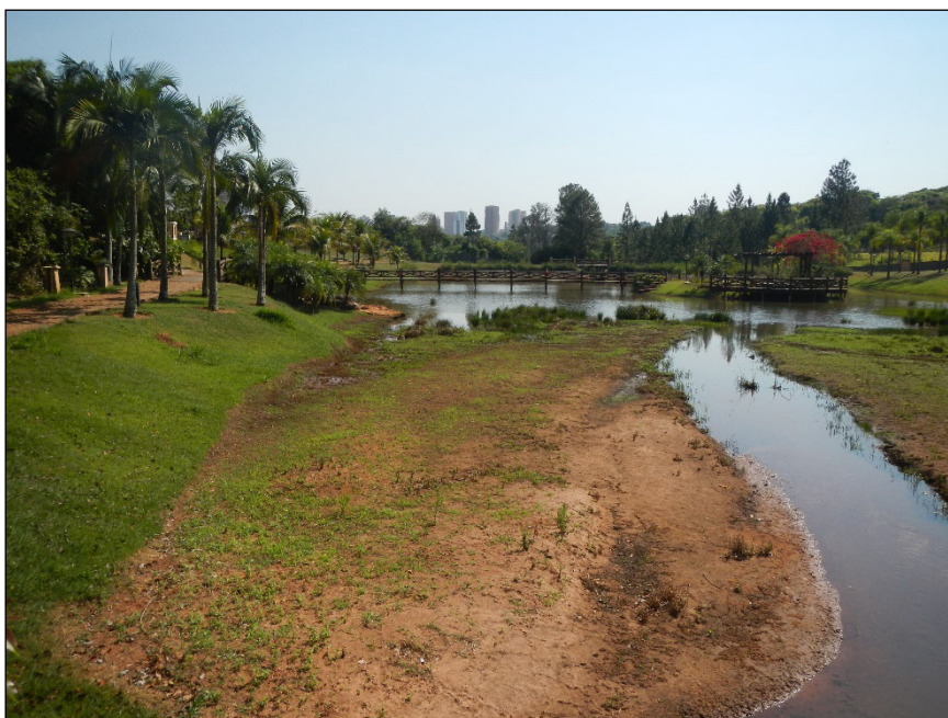
Figura 5. Assoreamento em lago de empreendimento no município de Bauru - SP, observado em 2017. Notar o grande volume de sedimentos depositados no leito do corpo d'água.
