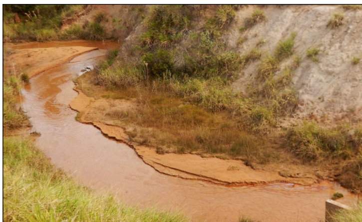
Figura 2. Assoreamento em corpo d'água, no município de Avaré em SP, registrada em 2019. Observar o solo arenoso depositado no pé do talude.
