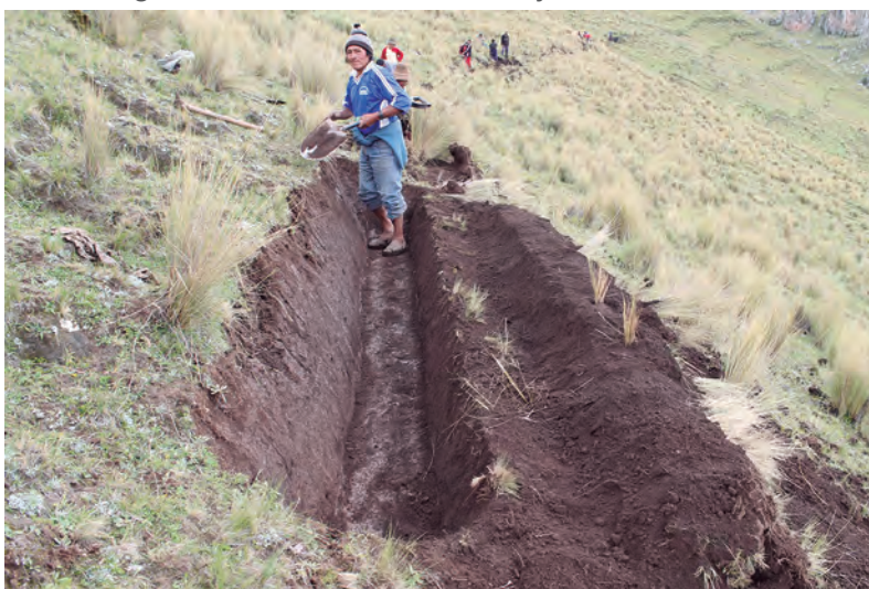
Figura 4. Construcción de zanjas de infiltración
