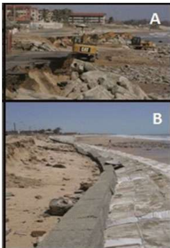
Figura 6. (A) Erosão na Praia do Icaraí, situada 25 km a sotamar do Porto do Mucuripe, a qual resulta das intervenções realizadas no litoral de Fortaleza e nas áreas em torno do Porto do Mucuripe. A ascensão mundial do nível do mar também deve ser um fator produtor dessa erosão. (B) Bag-wall instalado na Praia do Icaraí nos anos 2010, já destruído pelas ondas.
