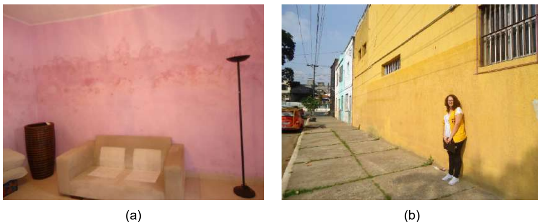
Figura 6. Marca da altura da lâmina d'água no evento de inundação de 11/03/2020, no interior de uma residência (a) e no muro externo de uma indústria (b), localizados no Trecho 1, próximo à foz do Córrego Ipiranga, São Paulo/SP
