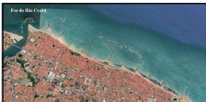
Figura 4. Espigões costeiros instalados no litoral de Fortaleza, para proteger a linha de costa da erosão resultante da interrupção da corrente longitudinal (deriva litorânea) produzida pelo porto e estruturas associadas, construídas a barlamar (a leste da área ilustrada) (Fonte: Imagem Google Earth, 2019).
