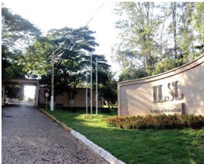
Figura 2. Portal de entrada atual, do Instituto "Lauro de Souza Lima" Bauru/SP.
